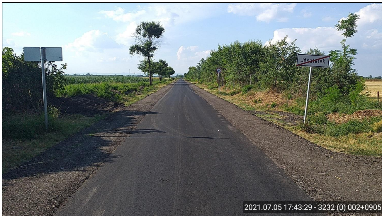
1-2. kép: 3232. jelű Jászjákóhalma-Jásztelek összekötő út nagyfelületű burkolatjavítása (előtte-utána)
