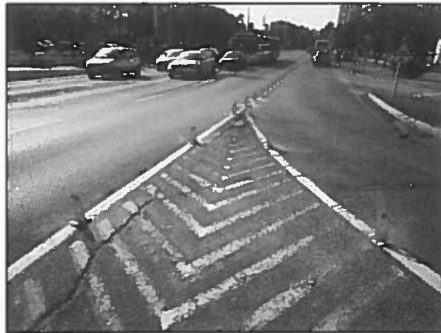
43-44. kép: Sávelválasztó jelzőfülek telepítése, útburkolati jelek módosítása balesetmegelőzési célból
