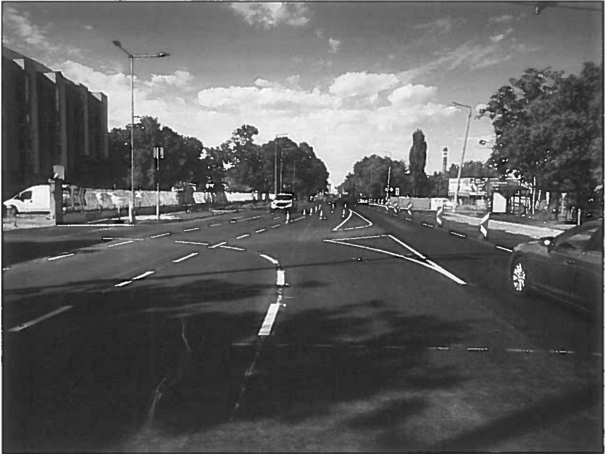
16-17. kép: Szolnok, Megyei Kórház jelzőlámpás csomópont építése
