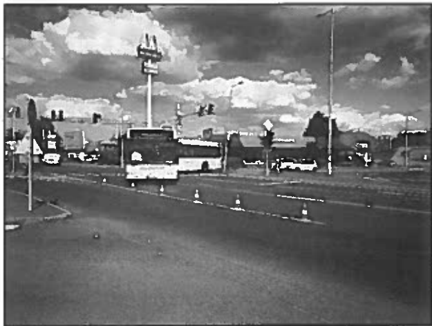
43-44. kép: Sávelválasztó jelzőfülek telepítése, útburkolati jelek módosítása balesetmegelőzési célból
