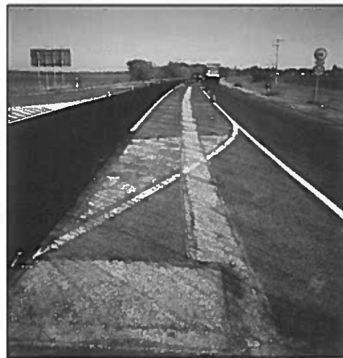
45-46. kép: 4-34. számú főutak csatlakozásában besorolást elősegítő sáv kialakítása
