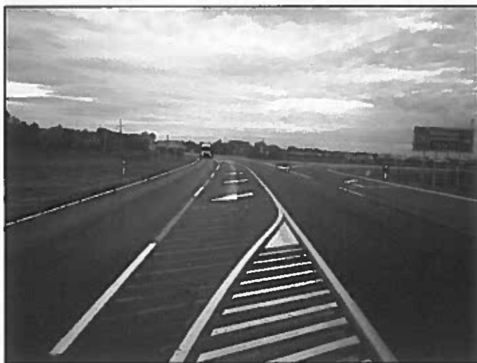
45-46. kép: 4-34. számú főutak csatlakozásában besorolást elősegítő sáv kialakítása
