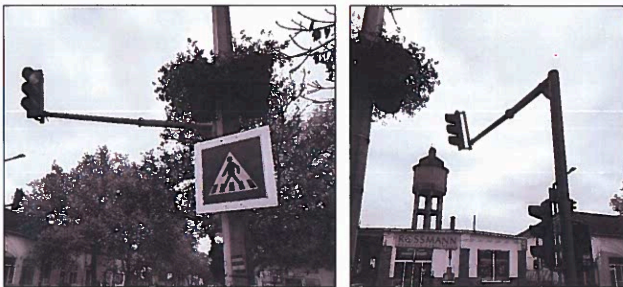
41-42. kép: Útfelújítás keretében magasabb fényvisszavető képességűre cserélt közúti jelzőtábla és forgalomirányító fényjelzőkészülék oszlopfestése
