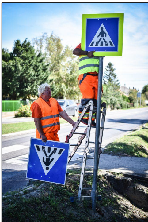
14-15. kép: Kijelölt gyalogos-átkelőhely jelzőtáblák kihelyezése
